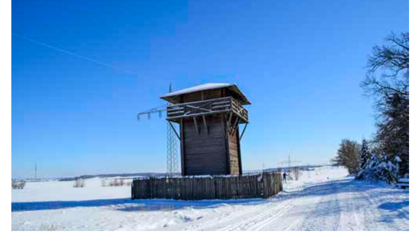
Die Raitenbacher Loipe führt direkt am Nachbau eines Limes-Wachturms vorbei – und entlang der 110-kV-Leitung, die zukünftig den Strom der neuen Windräder abtransportieren soll
